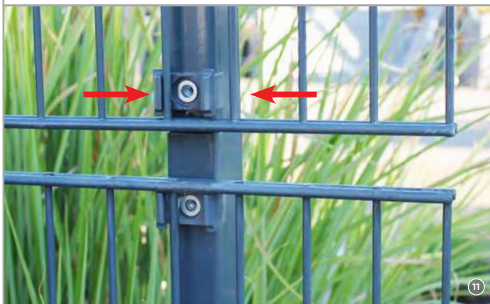
Abb. 3 Gittermatte an der Verlängerung anbringen!
