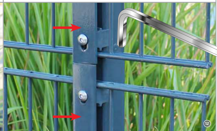
Abb. 4 Abdeckleiste fest verschrauben!
