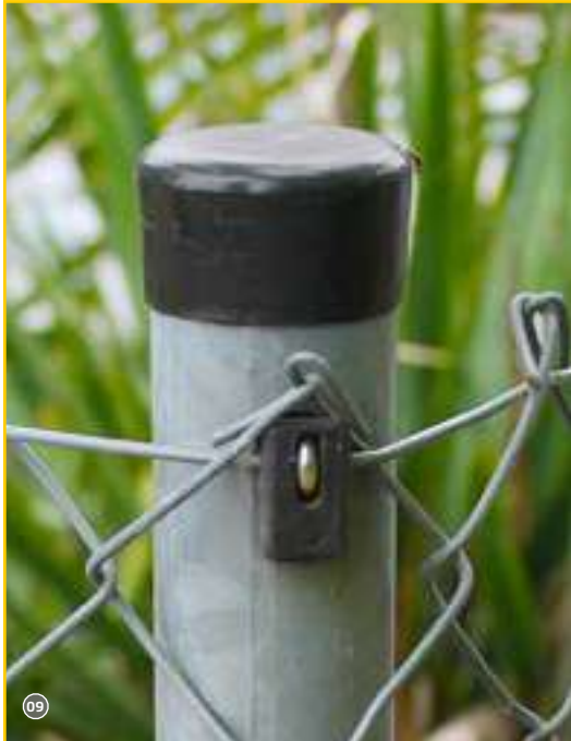
Fertig montierter Maschendrahtzaun!
